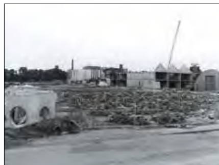
Foto boven: Start bouw wijk Tattersall*
